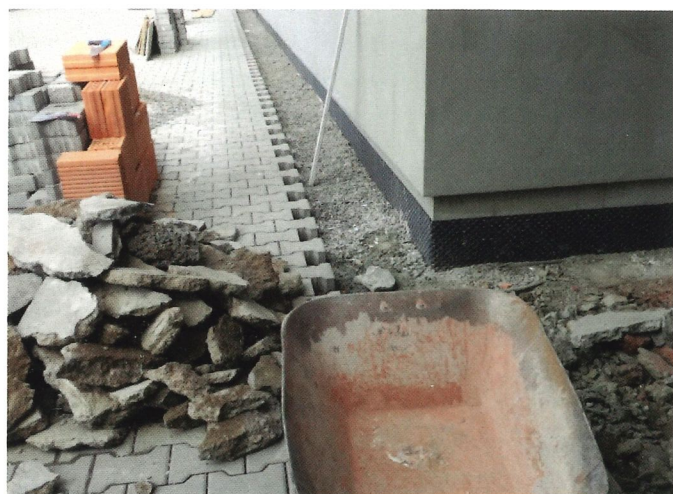
Přestavba dílny finišuje
